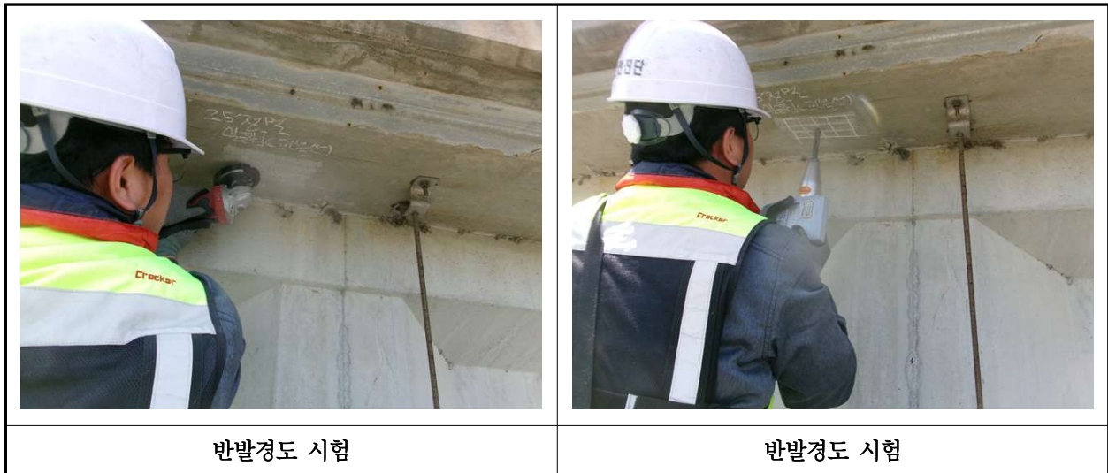
【사진 39.4.2】 반발경도시험 현장사진
