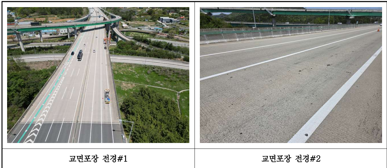
【사진 39.3.20】 교면포장 전경
