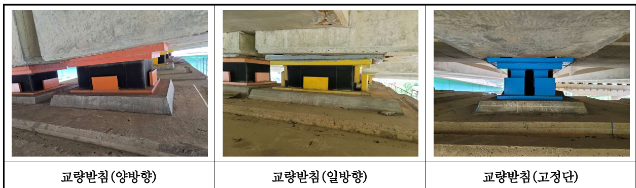
【사진 39.3.13】 교량받침 전경
