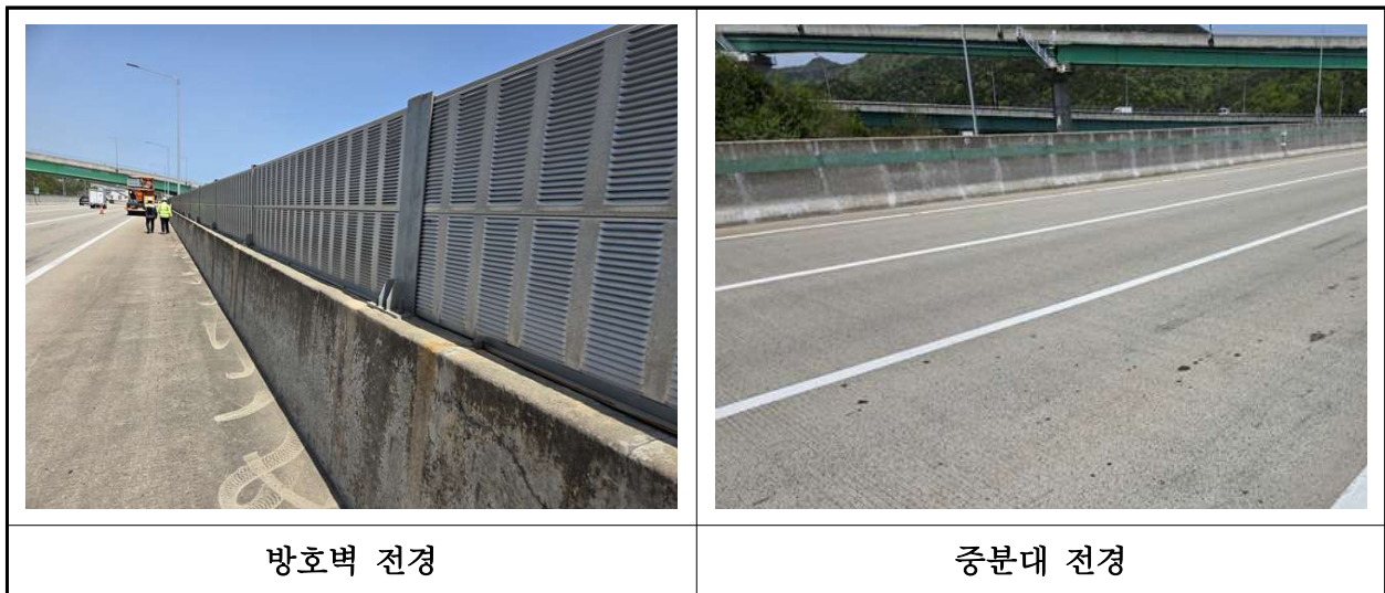
【사진 39.3.24】 방호벽 및 중분대 전경
