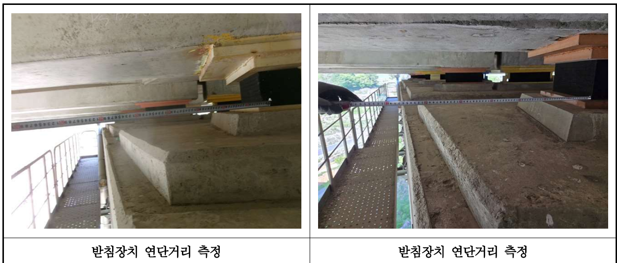
【사진 39.3.15】 교량받침장치 연단거리측정
