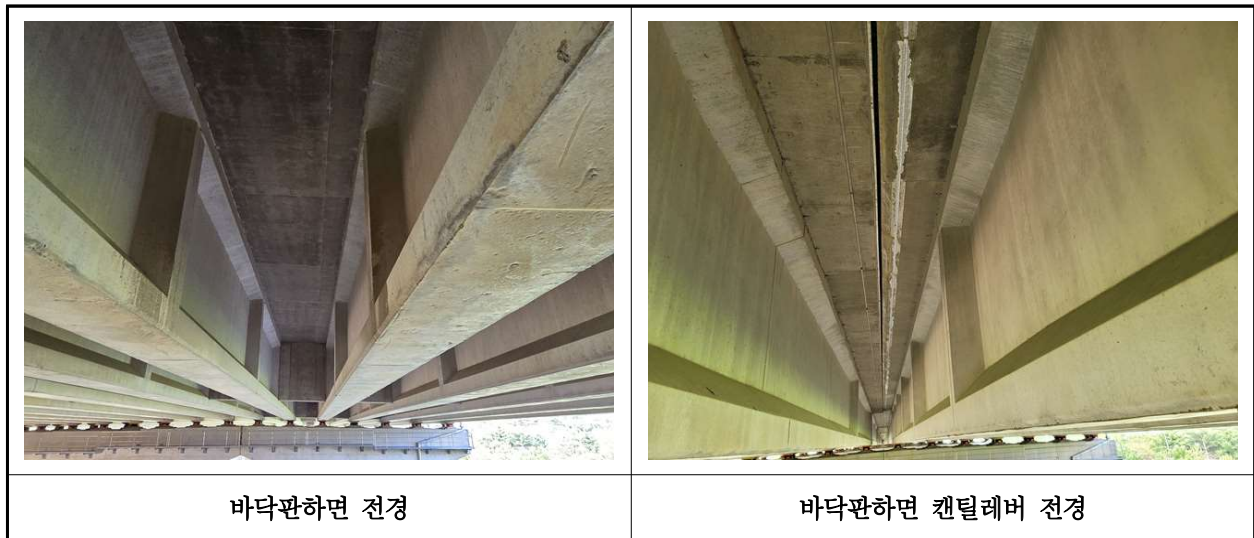
【사진 39.3.2】 바닥판하면 전경
