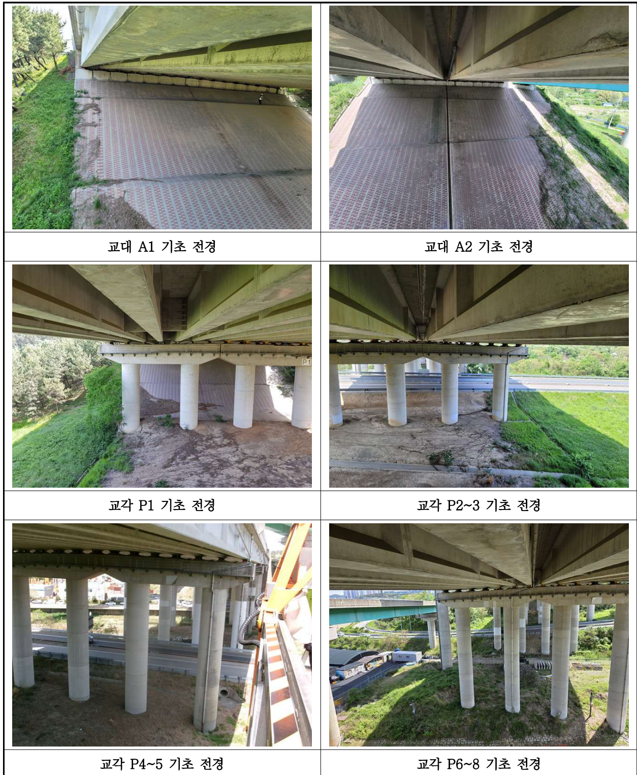
【사진 39.3.12】 기초 전경
