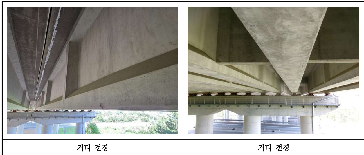
【사진 39.3.4】 거더 전경
