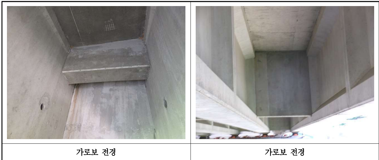
【사진 39.3.6】 가로보 전경
