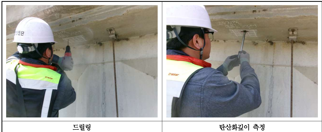
【사진 39.4.3】 탄산화 깊이 측정 현장사진
