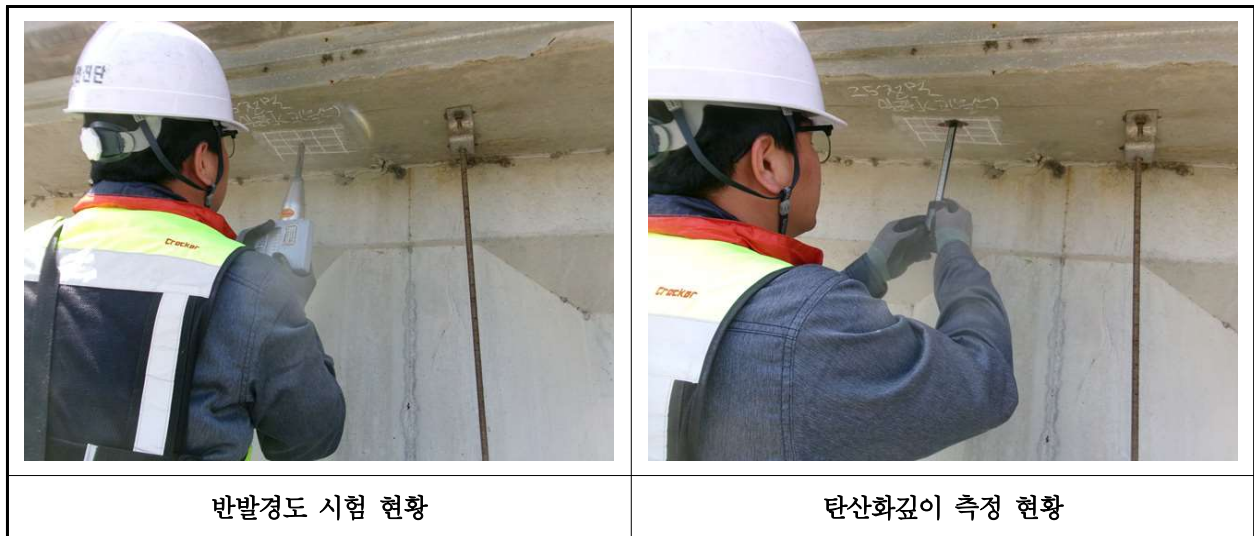
【사진 39.4.1】 콘크리트 내구성조사 현황
