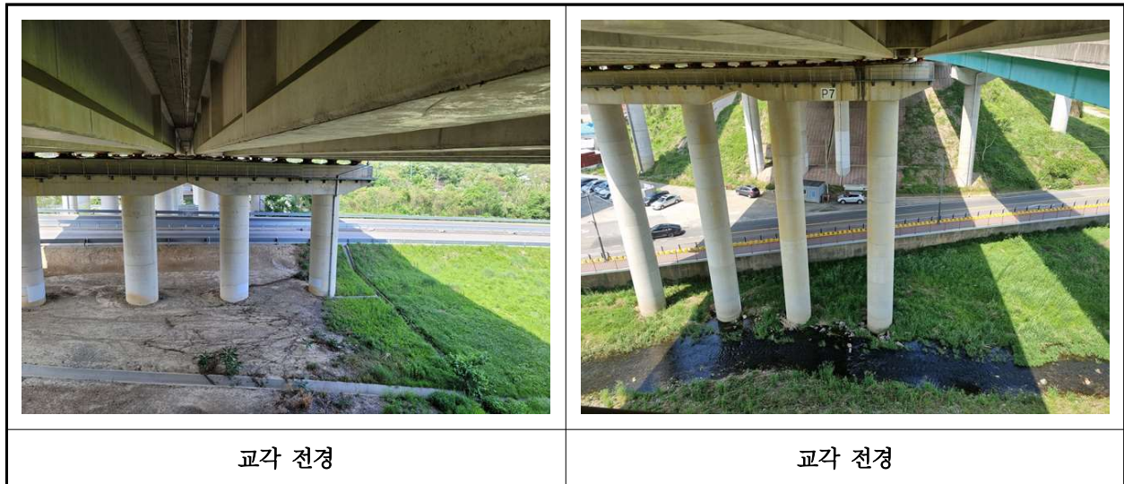
【사진 39.3.10】 교각 전경
