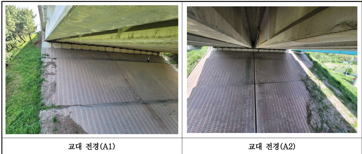
【사진 39.3.8】 교대 전경
